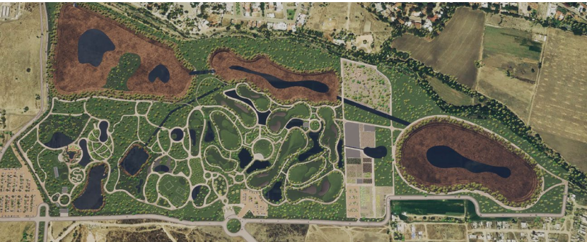
Proyecto Parque La Queretana. Cortesía de Secretaría de Obras Públicas Municipales
