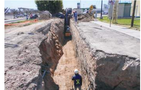
Imagen 66. Proceso de la Obra 2016-0271.
