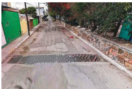
Imagen 31. Antes de la Obra 2016-0129.
