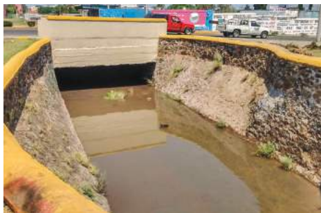
Imagen 23. Antes de la Obra 2016-0100.
