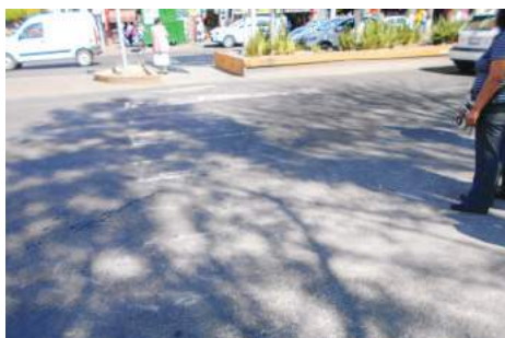
Imagen 47. Antes de la Obra 2016-0246.
