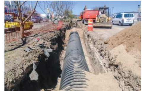
Imagen 74. Proceso de la Obra 2016-0276.
