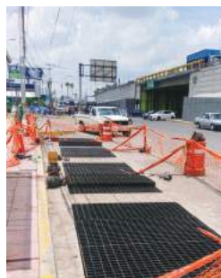
Imagen 102. Proceso de la Obra 2017-0138.
