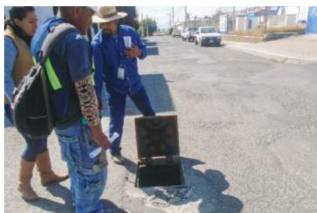
Imagen 43. Antes de la Obra 2016-0244.
