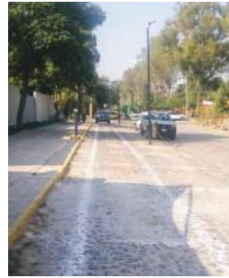
Imagen 113. Antes de la Obra 2017-0235.
