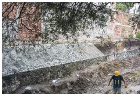
Imagen 22. Proceso de la Obra 2016-0081.
