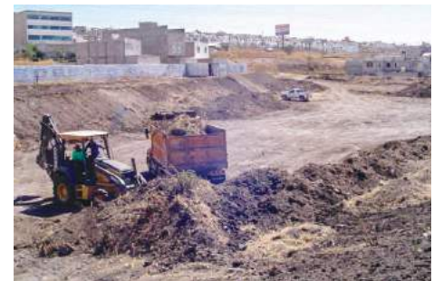
Imagen 84. Proceso de la Obra 2017-0035.
