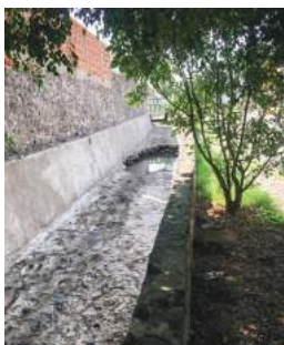
Imagen 109. Antes de la Obra 2017-0214.
