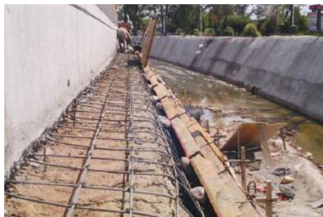
Imagen 14. Proceso de la Obra 2016-0002.
