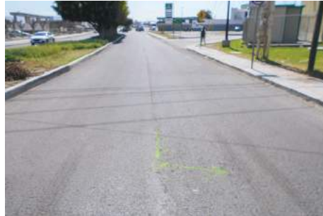
Imagen 65. Antes de la Obra 2016-0271.
