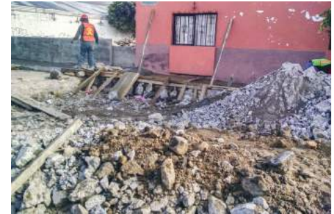
Imagen 18. Proceso de la Obra 2016-0037.
