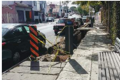
Imagen 67. Antes de la Obra 2016-0272.
