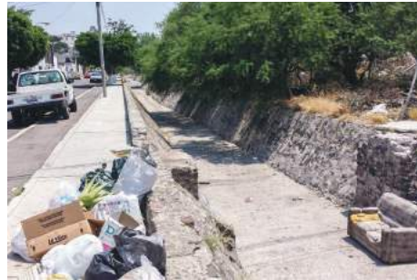
Imagen 17. Antes de la Obra 2016-0037.
