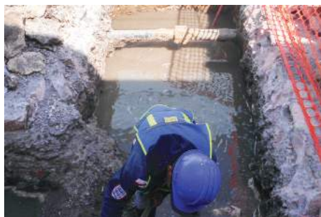
Imagen 40. Proceso de la Obra 2016-0241.
