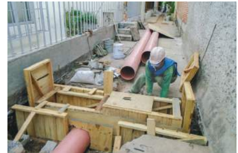
Imagen 28. Proceso de la Obra 2016-0116.
