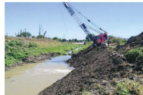
Imagen 10. Proceso de la Obra 2015-0346.
