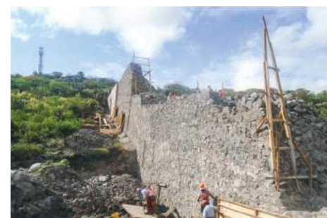
Imagen 12. Proceso de la Obra 2015-0366.
