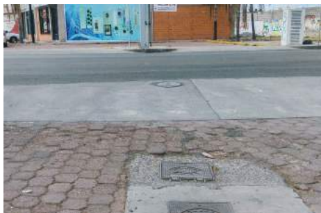
Imagen 37. Antes de la Obra 2016-0240.
