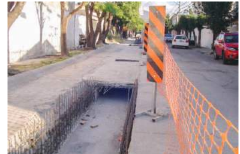
Imagen 34. Proceso de la Obra 2016-0143.
