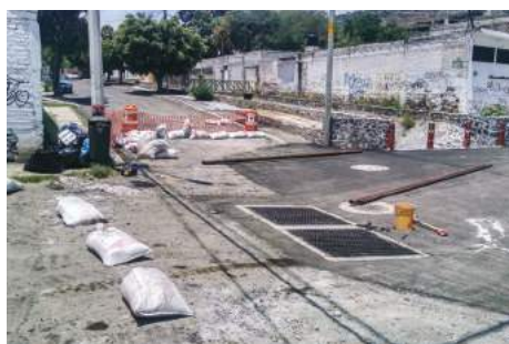
Imagen 16. Proceso de la Obra 2016-0022.
