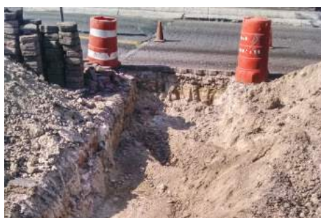
Imagen 72. Proceso de la Obra 2016-0275.
