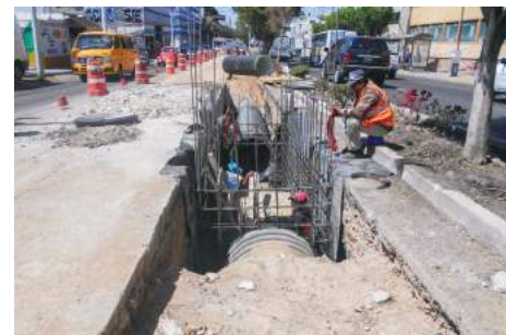
Imagen 42. Proceso de la Obra 2016-0243.
