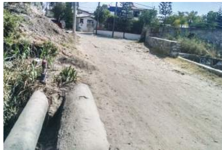
Imagen 75. Antes de la Obra 2016-0278.
