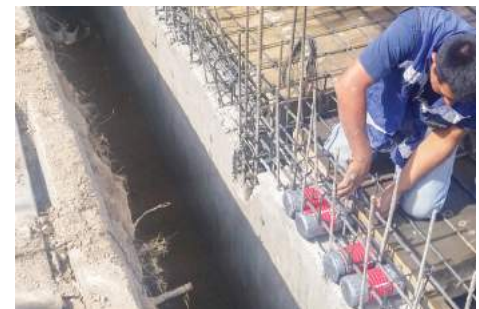
Imagen 36. Proceso de la Obra 2016-0144.
