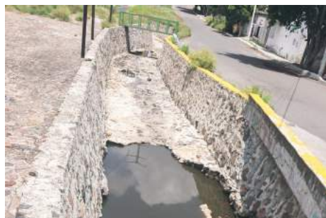
Imagen 89. Antes de la Obra 2017-0058.
