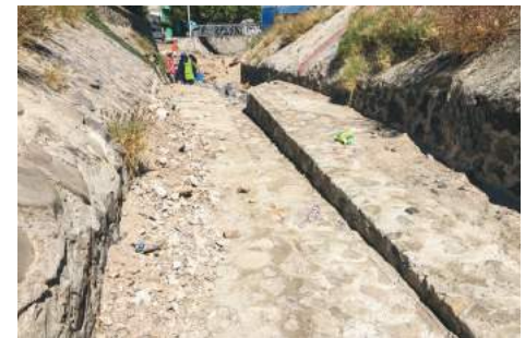
Imagen 20. Proceso de la Obra 2016-0038.
