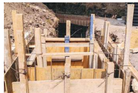
Imagen 52. Proceso de la Obra 2016-0248.
