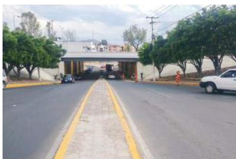
Imagen 69. Antes de la Obra 2016-0274.
