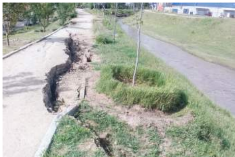
Imagen 116. Antes de la Obra 2017-0243.
