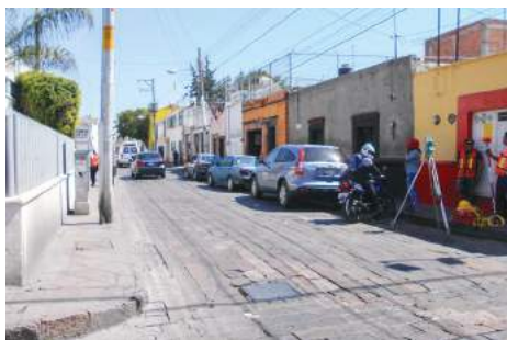
Imagen 39. Antes de la Obra 2016-0241.
