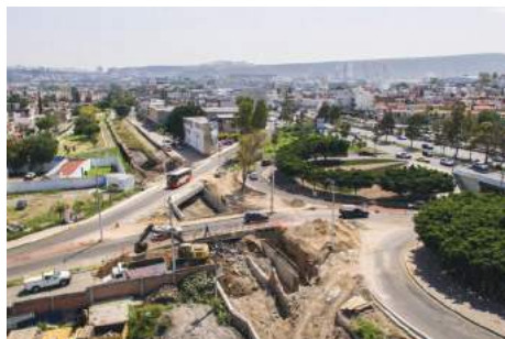
Imagen 24. Proceso de la Obra 2016-0100.
