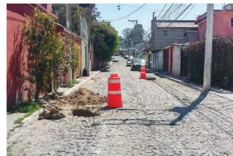
Imagen 50. Proceso de la Obra 2016-0247.
