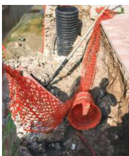
Imagen 111. Antes de la Obra 2017-0215.
