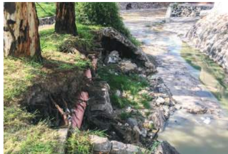
Imagen 107. Antes de la Obra 2017-0213.
