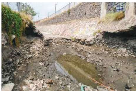
Imagen 5. Antes de la Obra 2015-0337.
