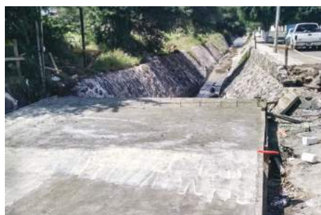
Imagen 15. Antes de la Obra 2016-0022.
