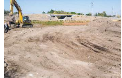
Imagen 82. Proceso de la Obra 2017-0034.
