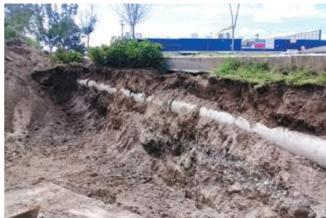
Imagen 117. Proceso de la Obra 2017-0243.
