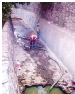
Imagen 110. Proceso de la Obra 2017-0214.
