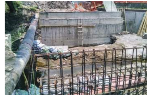
Imagen 76. Proceso de la Obra 2016-0278.
