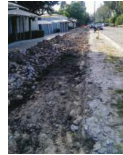
Imagen 114. Proceso de la Obra 2017-0235.
