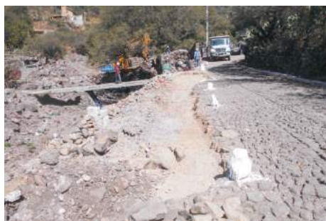
Imagen 119. Proceso de la Obra 2017-0259.
