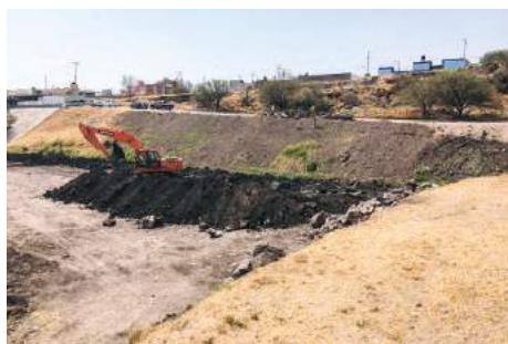
Imagen 127. Proceso de la Obra 2018-0016.
