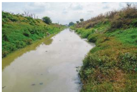
Imagen 9. Antes de la Obra 2015-0346.
