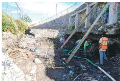
Imagen 6. Proceso de la Obra 2015-0337.
