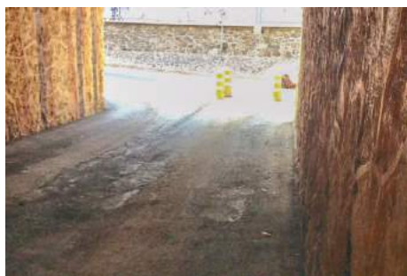
Imagen 56. Proceso de la Obra 2016-0263.
