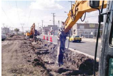
Imagen 78. Proceso de la Obra 2017-0010.
