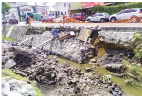
Imagen 94. Proceso de la Obra 2017-0062.
