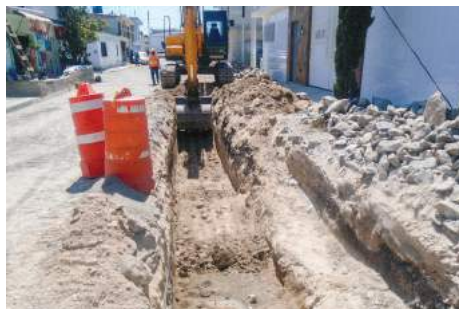
Imagen 46. Proceso de la Obra 2016-0245.
