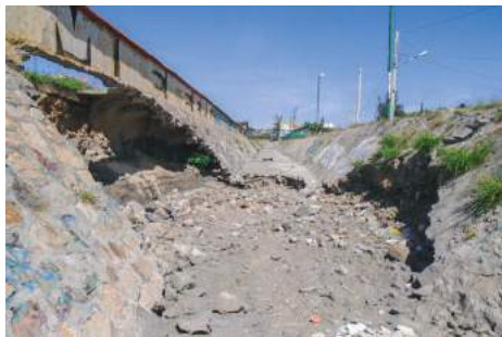
Imagen 7. Antes de la Obra 2015-0339.
