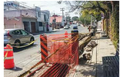
Imagen 68. Proceso de la Obra 2016-0272.
