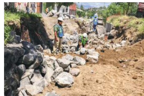
Imagen 90. Proceso de la Obra 2017-0058.
