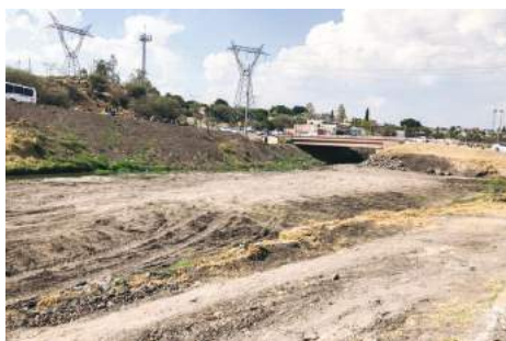
Imagen 126. Antes de la Obra 2018-0016.
