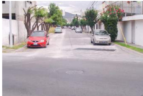
Imagen 33. Antes de la Obra 2016-0143.
