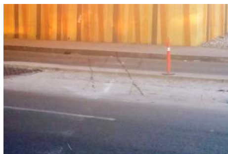
Imagen 51. Antes de la Obra 2016-0248.
