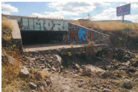
Imagen 85. Antes de la Obra 2017-0036.
