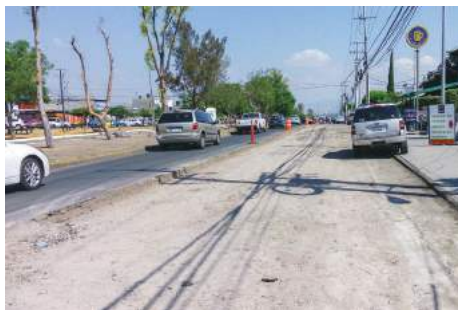
Imagen 104. Proceso de la Obra 2017-0147.
