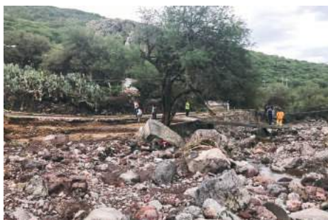
Imagen 118. Antes de la Obra 2017-0259.
