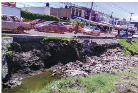
Imagen 93. Antes de la Obra 2017-0062.
