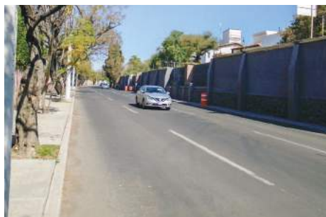
Imagen 57. Antes de la Obra 2016-0266.
