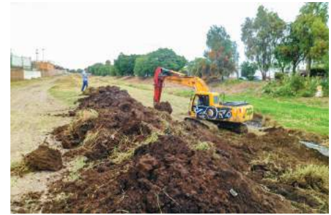
Imagen 98. Proceso de la Obra 2017-0107.
