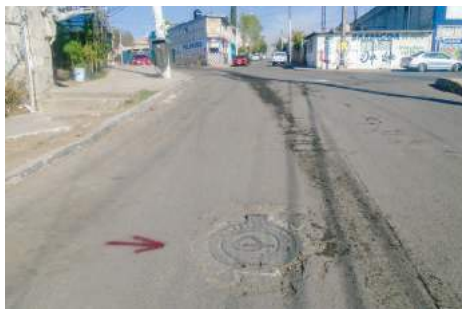
Imagen 45. Antes de la Obra 2016-0245.
