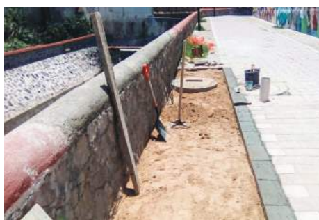
Imagen 112. Proceso de la Obra 2017-0215.
