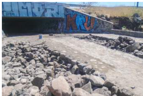
Imagen 86. Proceso de la Obra 2017-0036.
