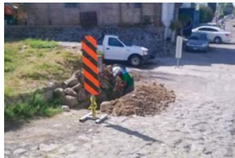
Imagen 19. Antes de la Obra 2016-0038.
