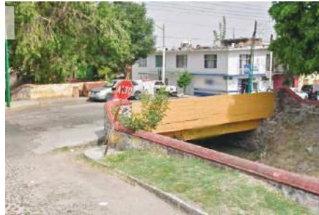
Imagen 25. Antes de la Obra 2016-0101.
