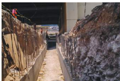
Imagen 70. Proceso de la Obra 2016-0274.
