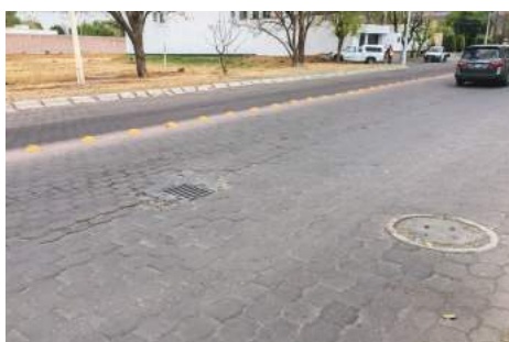
Imagen 71. Antes de la Obra 2016-0275.
