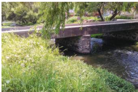
Imagen 29. Antes de la Obra 2016-0126.
