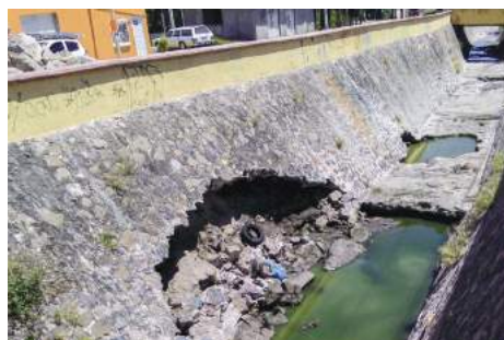
Imagen 91. Antes de la Obra 2017-0060.
