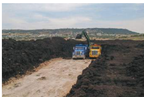
Imagen 88. Proceso de la Obra 2017-0037.
