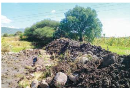
Imagen 96. Proceso de la Obra 2017-0106.
