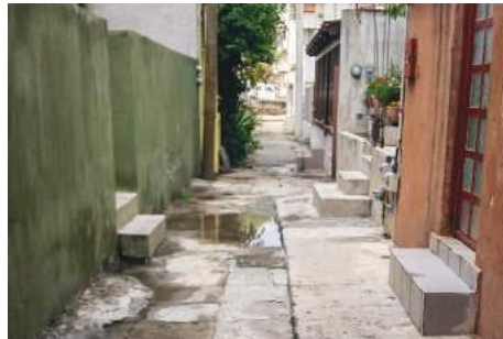
Imagen 27. Antes de la Obra 2016-0116.
