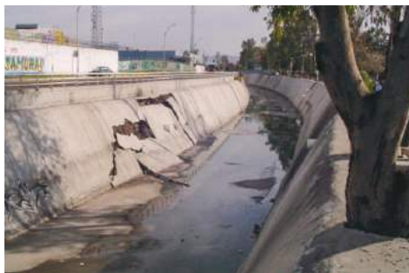
Imagen 13. Antes de la Obra 2016-0002.
