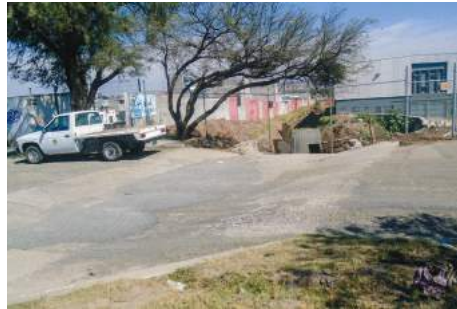
Imagen 73. Antes de la Obra 2016-0276.
