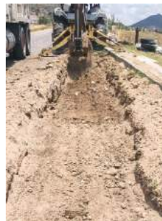
Imagen 80. Proceso de la Obra 2017-0017.
