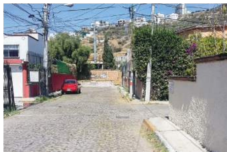
Imagen 49. Antes de la Obra 2016-0247.
