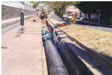
Imagen 54. Proceso de la Obra 2016-0249.
