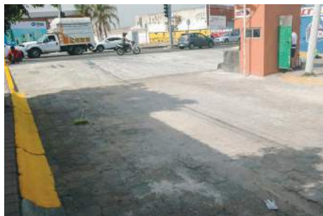
Imagen 38. Proceso de la Obra 2016-0240.
