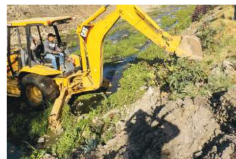
Imagen 125. Proceso de la Obra 2018-0008.
