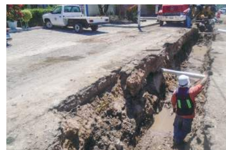
Imagen 44. Proceso de la Obra 2016-0244.
