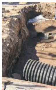
Imagen 62. Proceso de la Obra 2016-0269.
