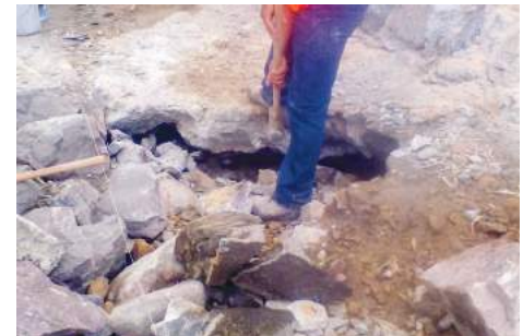
Imagen 108. Proceso de la Obra 2017-0213.
