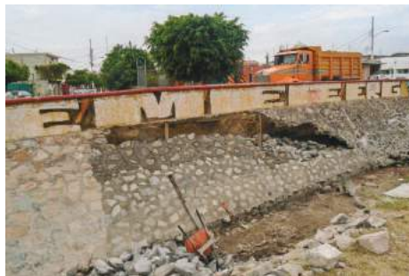
Imagen 8. Proceso de la Obra 2015-0339.
