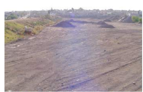
Imagen 106. Proceso de la Obra 2017-0171.
