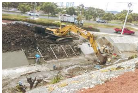
Imagen 123. Proceso de la Obra 2017-0270.
