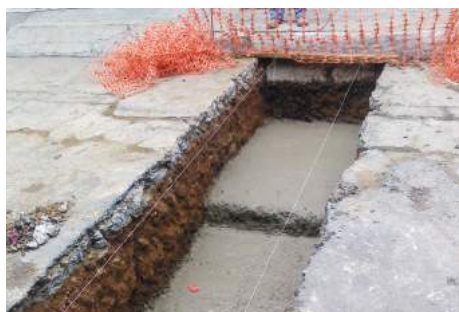
Imagen 32. Proceso de la Obra 2016-0129.
