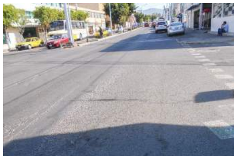
Imagen 41. Antes de la Obra 2016-0243.
