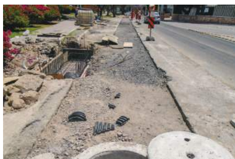
Imagen 64. Proceso de la Obra 2016-0270.
