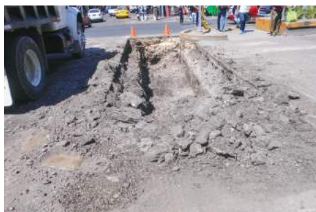
Imagen 48. Proceso de la Obra 2016-0246.
