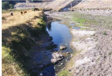
Imagen 81. Antes de la Obra 2017-0034.
