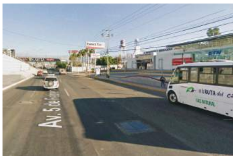
Imagen 101. Antes de la Obra 2017-0138.
