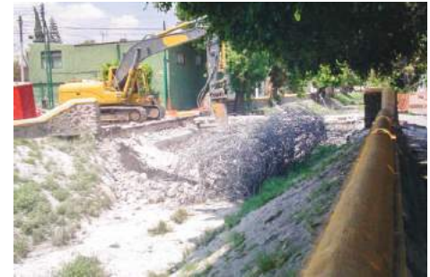
Imagen 26. Proceso de la Obra 2016-0101.
