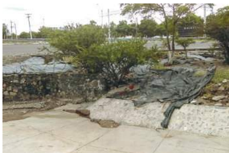
Imagen 122. Antes de la Obra 2017-0270.
