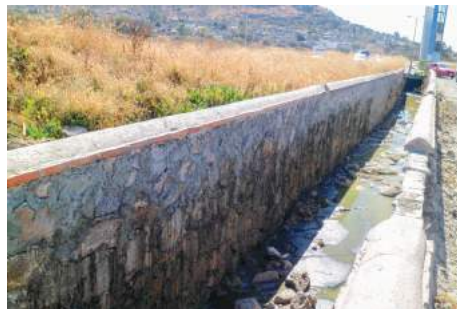
Imagen 115. Antes de la Obra 2017-0240.
