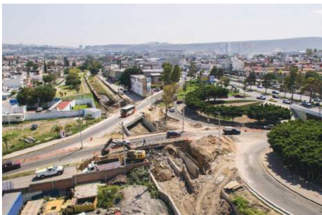
Imagen 2. Panorámica de la obra 2016-0100. ▲ Fuente: Elaboración propia.
