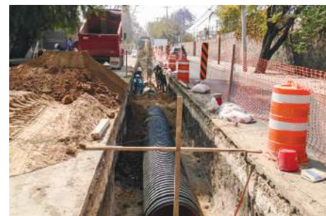
Imagen 58. Proceso de la Obra 2016-0266.
