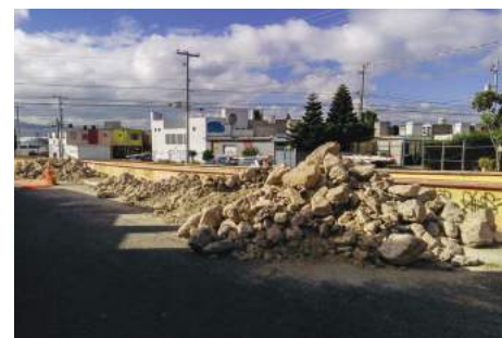
Imagen 92. Proceso de la Obra 2017-0060.
