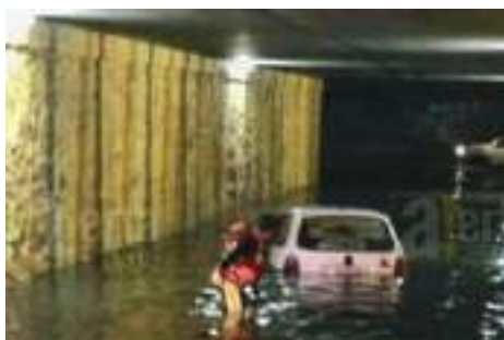
Imagen 55. Antes de la Obra 2016-0263.
